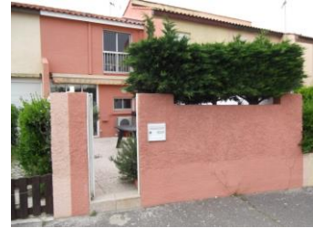
Villa, porte d'accès terrasse route de Vendres 8
